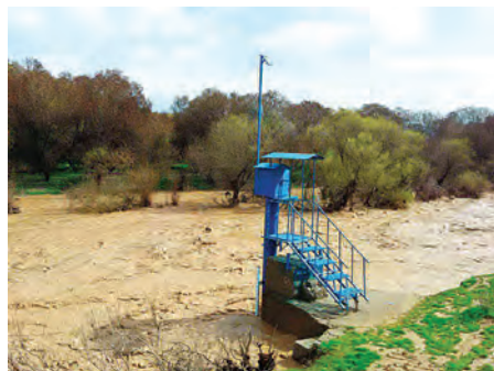
شکل ۲-۳- ایستگاه اندازه‌گیری آبدهی رود
