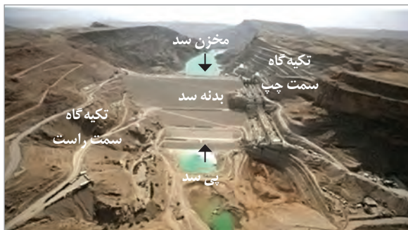
شکل ۴-۵- نمایی از بخش های مختلف یک سد
