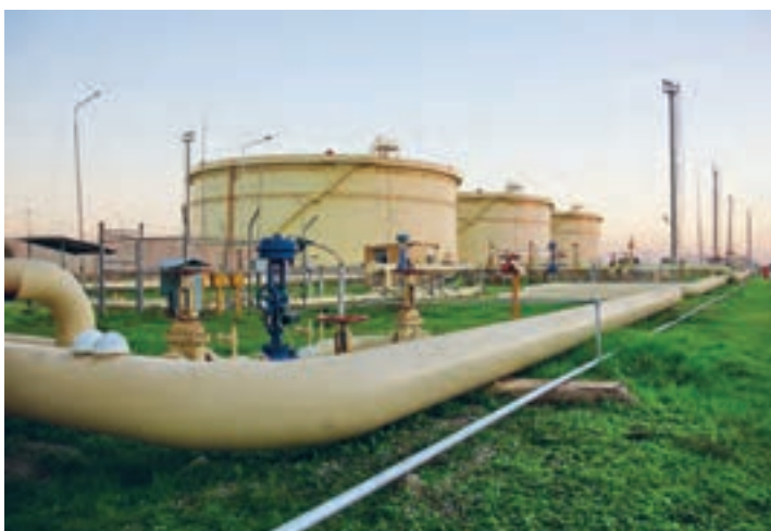
شکل ۲۱- نمایی از خطوط انتقال سوخت
