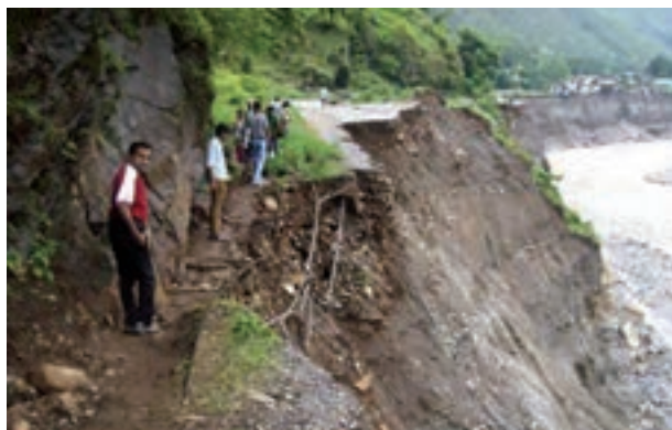
لغزش در اثر زیربُری رودخانه در هند
