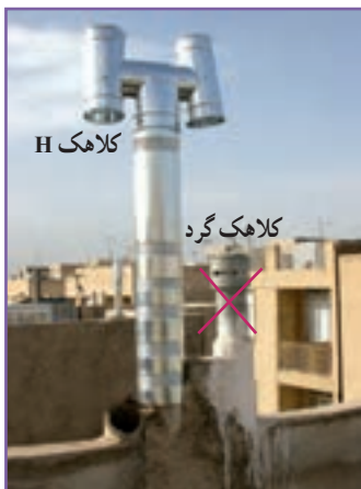
ب - فاصله بین دودکش تا کولر آبی و یا پ - برای خروجی دودکش هر دستگاه دریچه های تأمین هوای ساختمان دست کم گاز سوز یک کلاhek H نصب شود. سه متر باشد.
