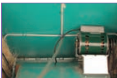
ح - آزمایش صحت مدار آب پخش کن
