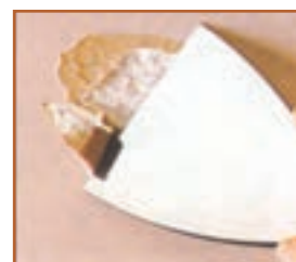
الف - باز کردن ترک‌ها
