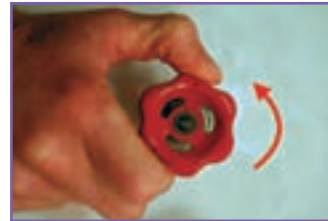
ح - باز کردن شیر فلکه اصلی
