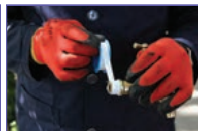
پ- پیچیدن نوار تفلون روی شیر نو
