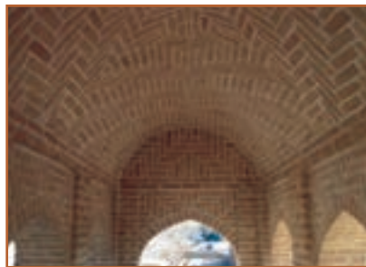
ب- استفاده از آجر برای سقف قوسی
