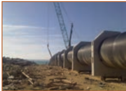
ت - احداث خطوط لوله
