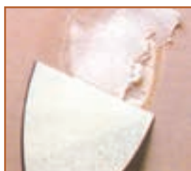
ب - لکه گیری و ترمیم ترک‌ها
