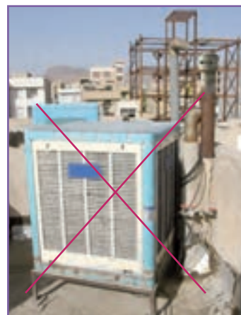
ب - فاصله بین دودکش تا کولر آبی و یا پ - برای خروجی دودکش هر دستگاه دریچه های تأمین هوای ساختمان دست کم گاز سوز یک کلاhek H نصب شود. سه متر باشد.
