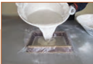
ث - ریختن ملات گچ در قالب
