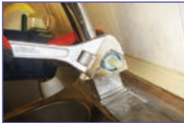
ث- باز کردن پیچ روی مغزی (گلند)
